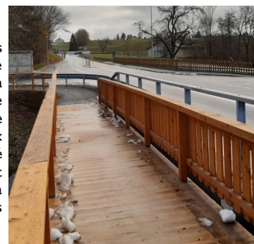
Le nouveau pont piéton sur la Bressonne, entre la Croix d'Or et Ropraz
